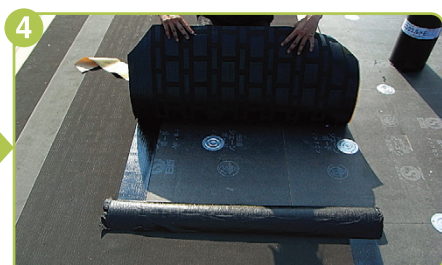
防水層の施工（平場1層目）
