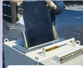
アスファルト投入
