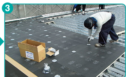
断熱材ディスク板留め
