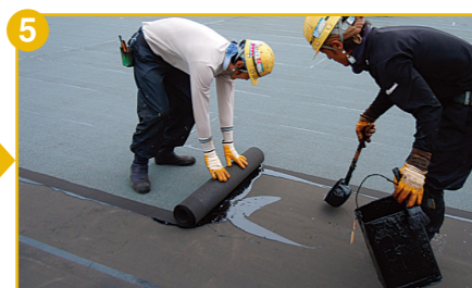
防水層の施工（平場2層目）
