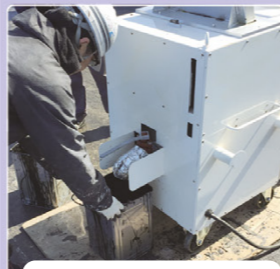
アスファルト排出
